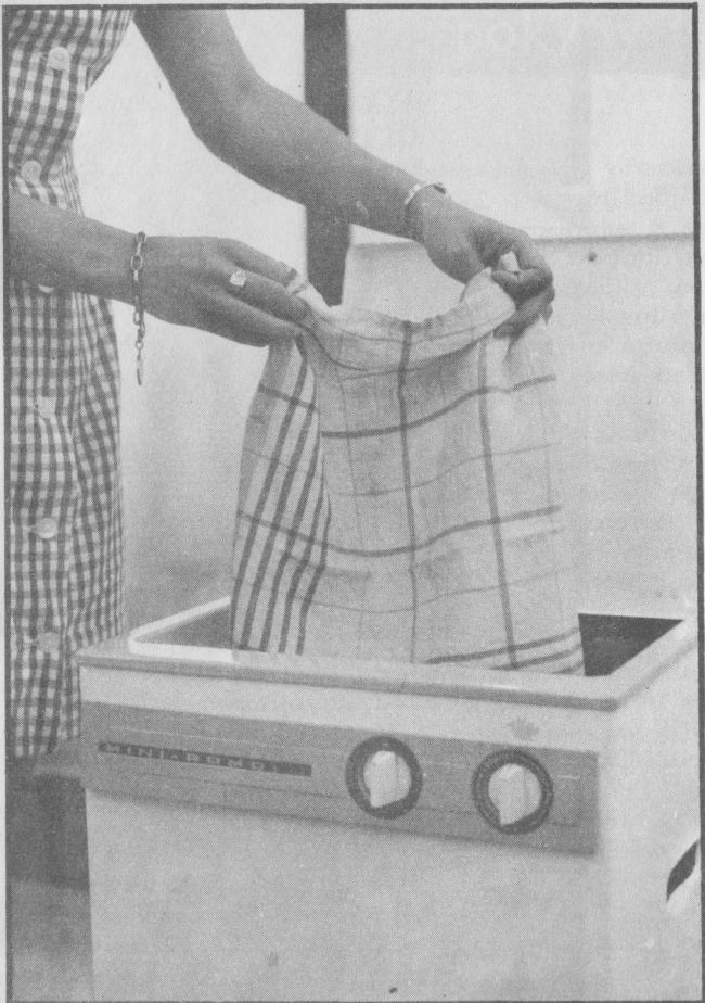
Nejdříve si ověřte, zda odtoková hadice pračky je rádně upevněna a uzavřena kulovým uzavěrem. Pračku naplňte teplou vodou až po značku hladiny. Teplota vody podle druhu prádla:
